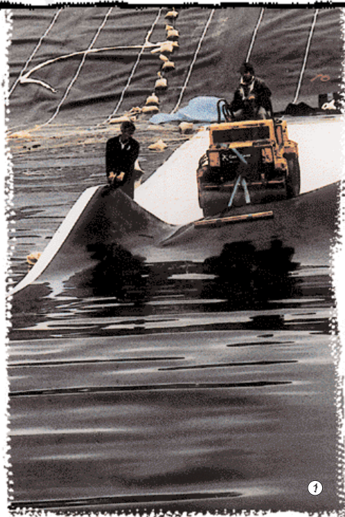
Étanchéification des casiers d'une décharge
